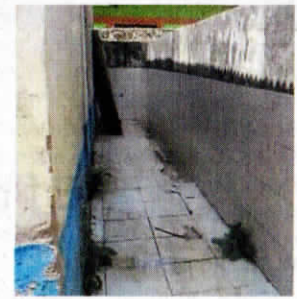
Die Jungentoilette soll einen Sichtschutz erhalten.
