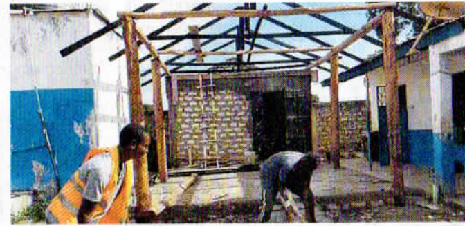
Baustart des Küchenanbaus.
