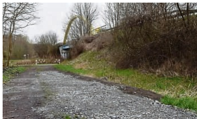
Nachher – eingeebnet und freigeschnitten: Die für den Weg zum Kanal zuständige Autobahn GmbH hat die Querneigung beseitigt, den Graben an der Seite befestigt sowie großzügig Äste und Zweige entfernt.
