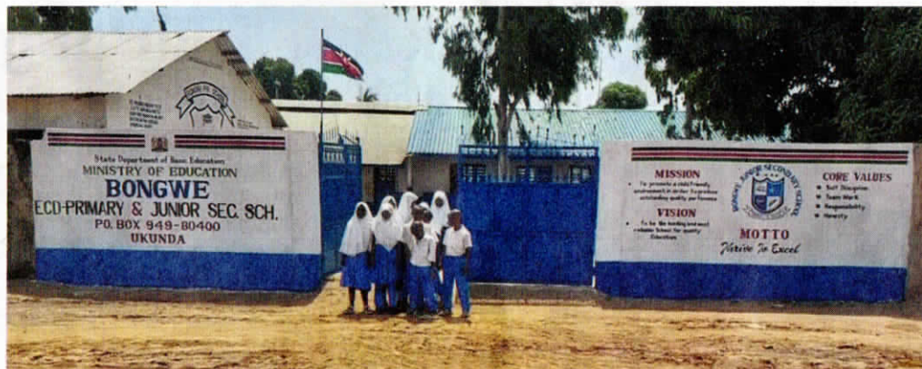
Renovierter Eingangsbereich am Schulgelände in Ukunda.
